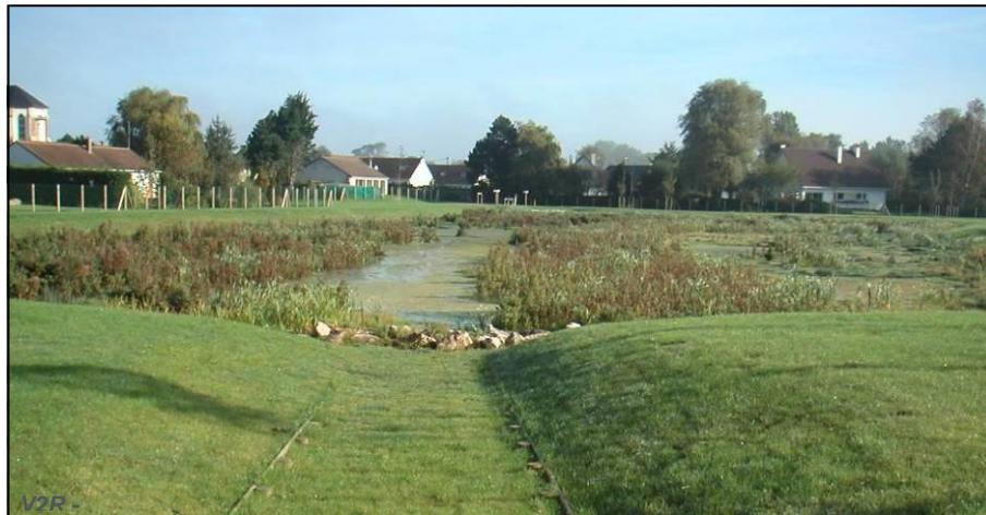
Photo exemple de bassin d'infiltration planté d'hélophytes :
