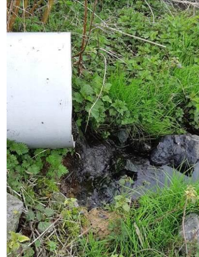
Canalisation de 400mm en entrée de bassin
